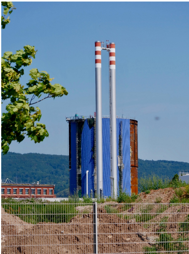
Abb. 2: Der im Bau befindliche Energiespeicher in Heidelberg Pfaffengrund (2019); Foto: Lutz Berger 2019.
