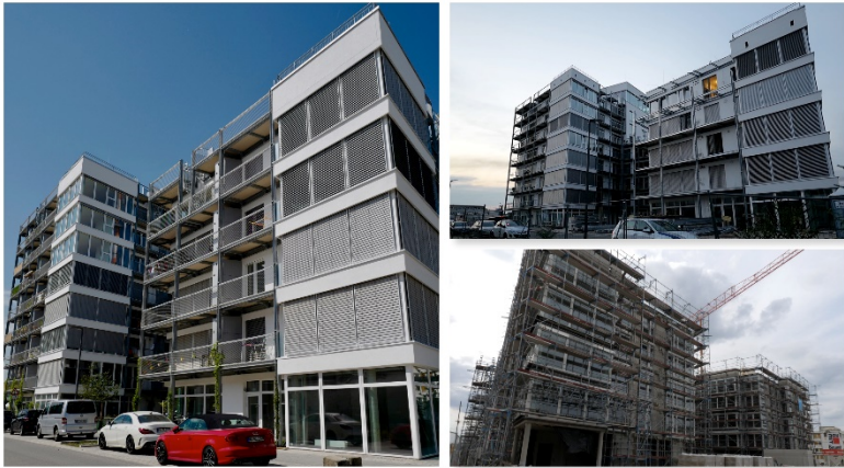
Abb. 1: Das Heidelberg Village in der Heidelberger Bahnstadt im Bau und nach Fertigstellung (2019); Fotos: Lutz Berger 2016–2019.
