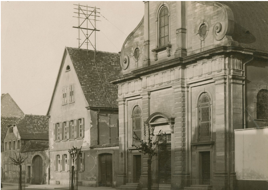
Abb. 6. Das reformierte Schulhaus stand nördlich der ehemals reformierten Kirche, der heutigen evangelischen Stadtkirche. Das Foto entstand um 1930 (Schwetzingen, Stadtarchiv, Foto 1508).
