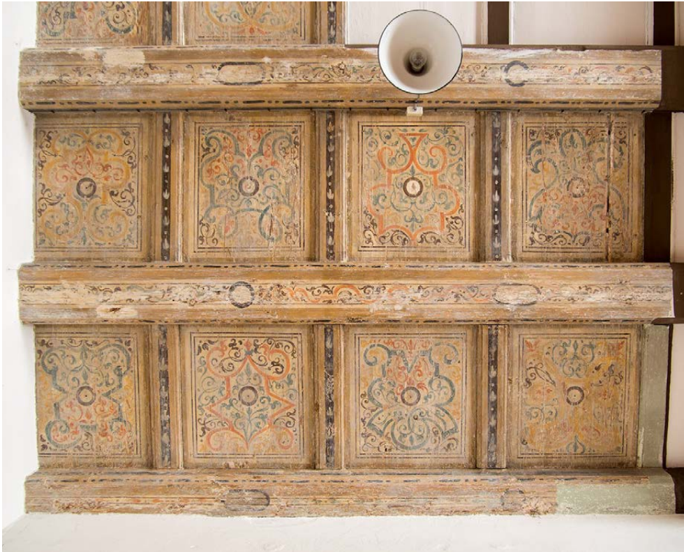
Abbildung 141. Prettin, Schloss Lichtenburg, Flügel D1, erstes Obergeschoss, Schlafkammer des Hauptappartements (1.24), Holzbalkendecke mit Einschubbrettern, um 1580
