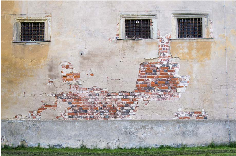
Abbildung 110. Prettin, Schloss Lichtenburg, Westflügel (B), südlicher Teil der Westfassade, Backsteinmauerwerk, 14. Jahrhundert, mit Fenstern aus dem 16. Jahrhundert
