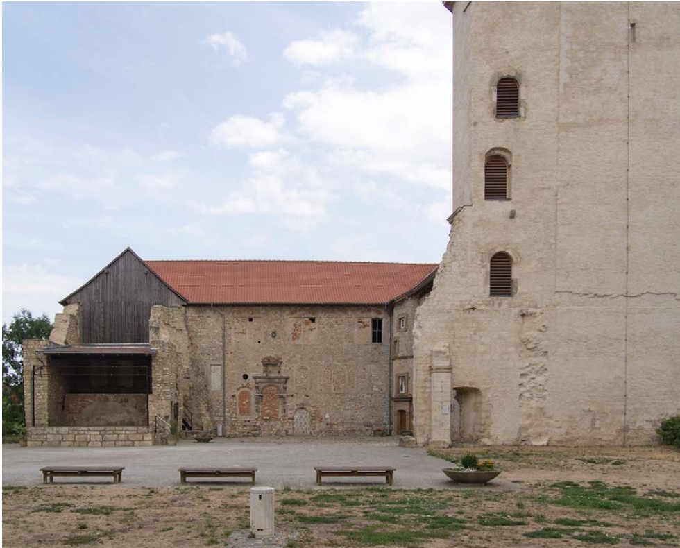
Abbildung 161. Osterwieck, Schloss Hessen, Schlosshof mit Burgturm (rechts), Ost- und Südflügel, Ausbau ab 1560 bis Mitte des 17. Jahrhunderts, Ansicht von Westen. In der Westfassade des Ostflügels zeigen drei Rundbogenfenster und ein aufwendig gestaltetes Portal von 1654(i) die Lage der ehem. Schlosskapelle an.
