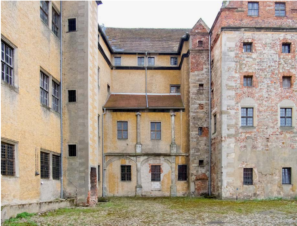
Abbildung 114. Prettin, Schloss Lichtenburg, Flügel D1 und D4, Nordfassade, östliche Loggia, 1577–1582
