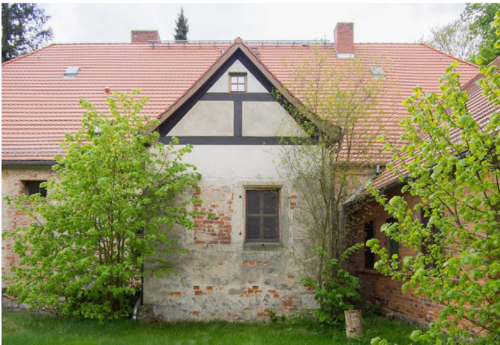
Abbildung 151. Jessen (Elster), Schloss Glücksburg, Nordfassade, Anbau, ehem. Badestube, um 1600/vor 1611
