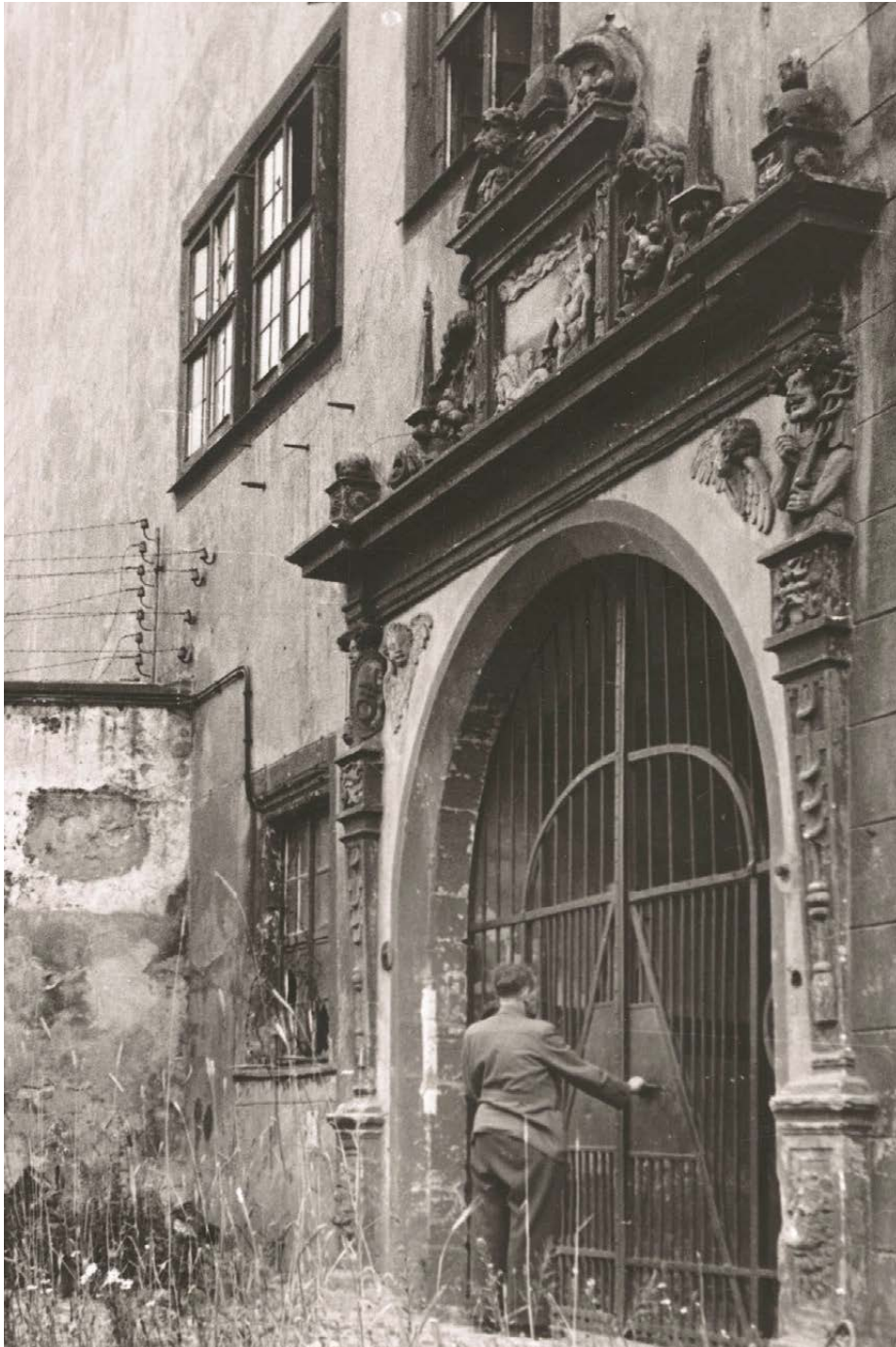
Abbildung 131. Prettin, Schloss Lichtenburg, Torbau, Nordfassade, Portal, 1615, Aufnahme von 1945
