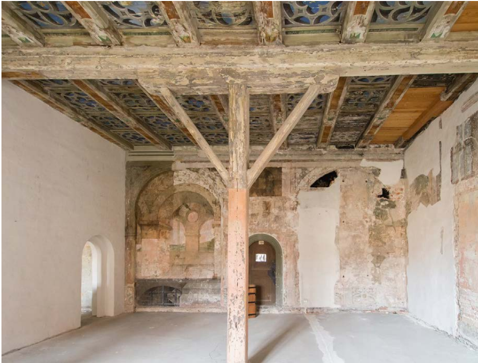
Abbildung 134. Prettin, Schloss Lichtenburg, Flügel D3, erstes Obergeschoss, Raum 1.36, Perspektivstube mit Wand- und Deckenmalerei, 1565 (?)/1577–1582, um 1635, um 1700, Ansicht von Westen
