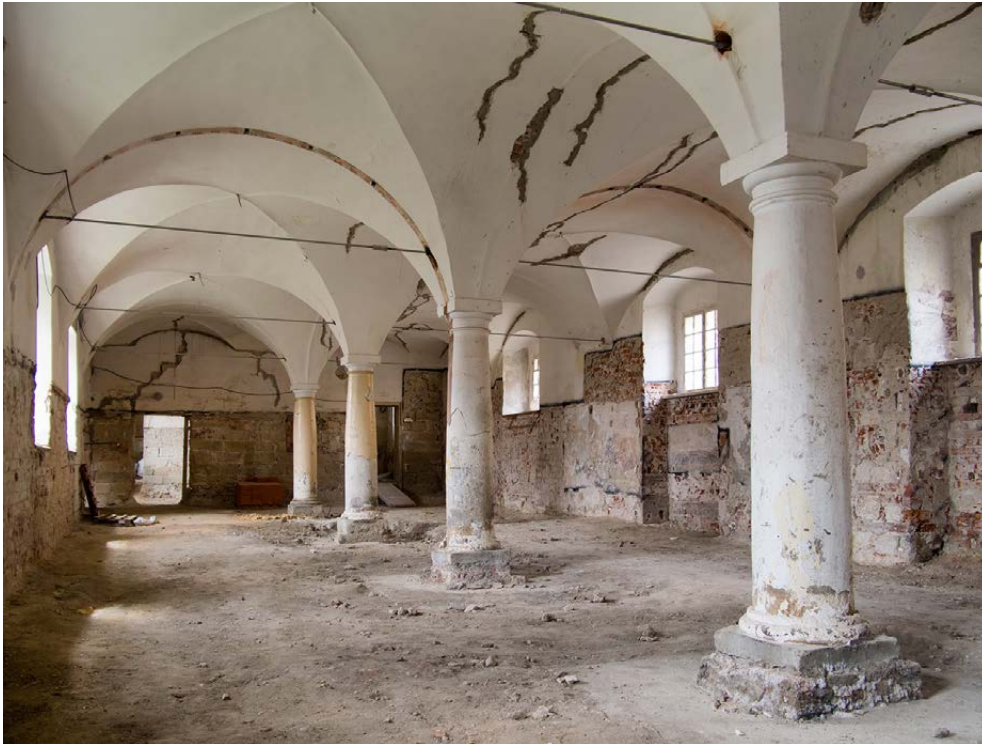
Abbildung 147. Prettin, Schloss Lichtenburg, Flügel A, Erdgeschoss, ehem. Marstall, 1577–1582, Ansicht von Osten
