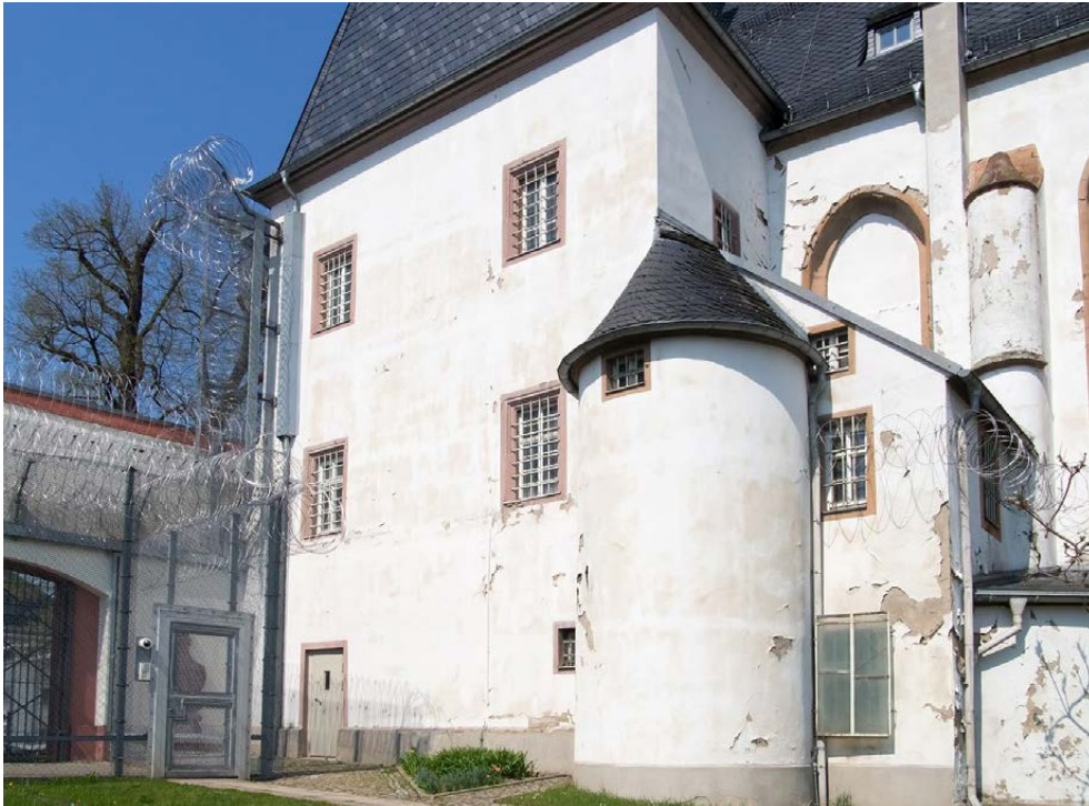
Abbildung 103. Waldheim, Schlosskapelle, Südanbau (ehem. Schösserei) mit Wendelstein, 16. Jahrhundert, Ausbau um 1601, Ansicht von Südosten
