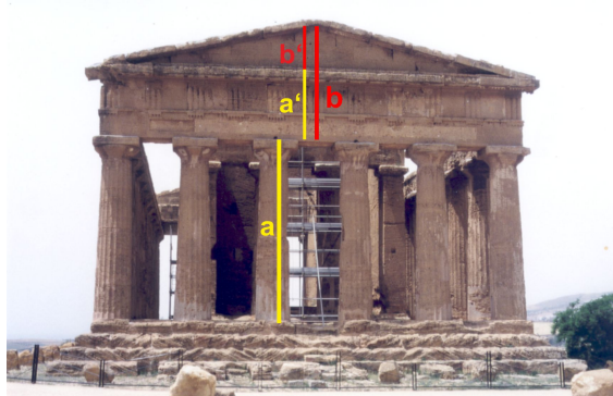
Abbildung 4: Dorischer Concordia-Tempel (um 440 v. Chr.), Agrigent, Sizilien. Die Proportionen von Höhe der Säulen und Fries ( a:b ) und innerhalb des Frieses ( a':b' ) entsprechen denen des Goldenen Schnittes ( \approx 1,61\dots ).
