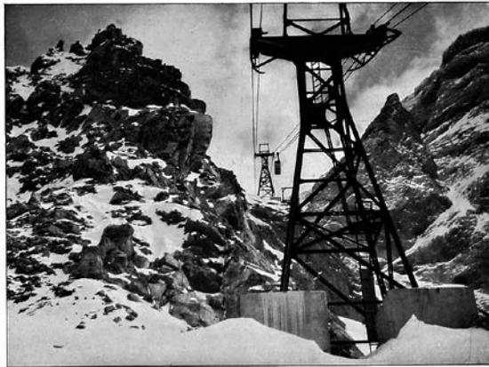
460. Die 1924–26 erbaute österreichische Seilschwebebahn von Ehrwald zur Zugspitze. — Die 3362 m lange Bahn überwindet 1580 m Höhenunterschied in 20 Minuten, das 48 mm starke Drahtseil läuft über 6 auf Eisenbeton ruhende Türme. Bergstation 2805 m (Zugspitzgipfel 2964 m).
