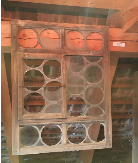
Abbildung 15. Großformatige, dünnwandige, leicht grünliche Glasscheiben eines Schiebefensters, vermutlich Originalfenster des Hoyerschen Hauses, erbaut 1604 in Gügleben/Ilmkreis. Thüringer Freilichtmuseum Hohenfelden.
