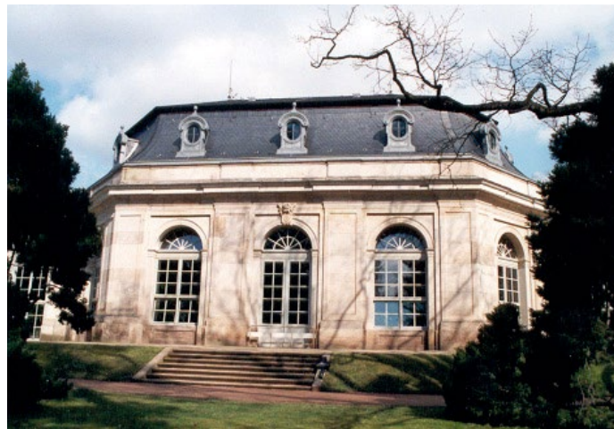
Abb. 11. Mittelbau Orangerie, ehemaliges Ringrennhaus, heutiger Zustand (Foto des Verfassers).
