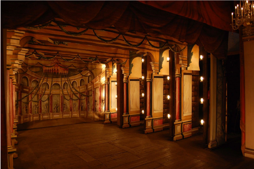
Abbildung 6. Blick auf die historische Bühne, deutlich sichtbar die mittige Hauptversenkung und die seitlichen Kulissenflügel.
