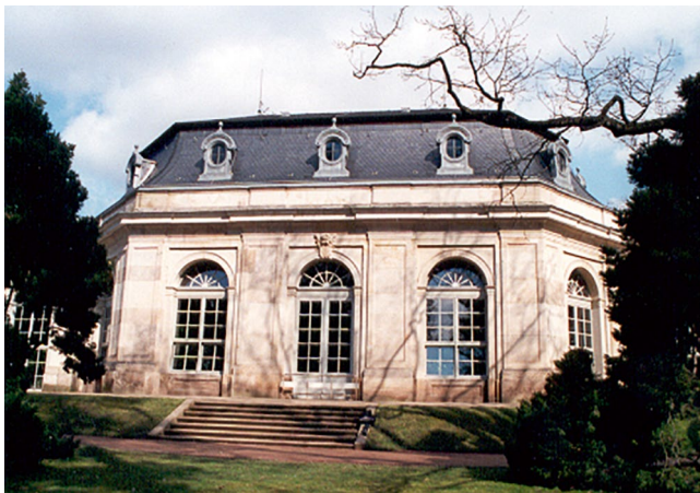
Abbildung 8. Mittelbau der Orangerie; ehem. Ringrennhaus (heutiger Zustand).
