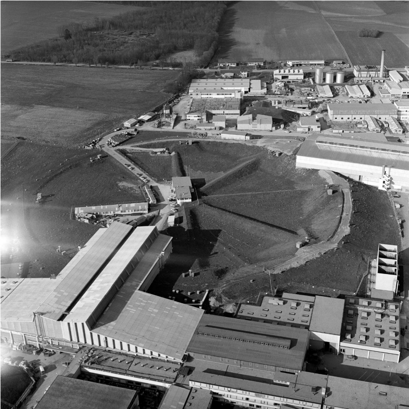
ABBILDUNG 6.3 Der erste große ringförmige Beschleuniger des CERN, das 28 GeV Proton-Synchrotron, unter einem Erdwall (Foto um 1965).
