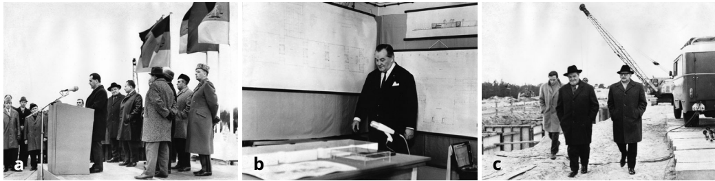
Abbildung 161. AMLO, Berlin-Wuhlheide, Grundsteinlegung. a: Ansprache von Günter Prey, 4.2.69, Fotografie, Architekturmuseum der TU München; b: Erläuterung des Bauvorhabens durch Richard Paulick, im Hintergrund Baupläne zum Projekt, 4.2.69, Fotografie, Architekturmuseum der TU München; c: Richard Paulick und zwei weitere Personen auf dem Weg zur Grundsteinlegung, 4.2.69, Fotografie, Architekturmuseum der TU München.
