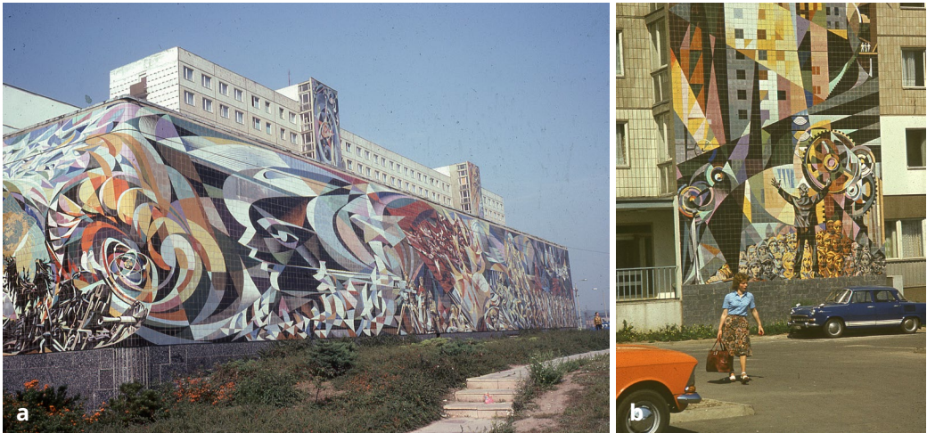
Abbildung 52. a: Josep Renau, Wandbild »Der Marsch der Jugend in die Zukunft«, Mensa des Bildungszentrums Halle-Neustadt, nach 1974, farbiges Diapositiv; b: Josep Renau, Wandbild »Die Beherrschung der Kräfte der Natur«, Bildungszentrums Halle-Neustadt, Detailansicht des linken Wandbilds am Internat, nach 1974, farbiges Diapositiv, Institut Valencià d'Art Modern, Generalitat/Depósito Fundación Renau, Valencia.
