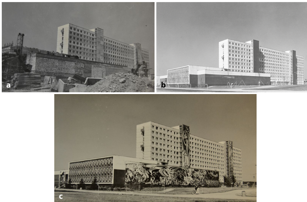
Abbildung 51. Josep Renau, Wandbilder am ehemaligen Bildungszentrum Halle-Neustadt. Zustand des Bildungszentrums und der Mensa vor der Anbringung der Wandbilder. a: Zustand der Baustelle vor der Anbringung der beiden Wandbilder, ca. 1970, Fotografie; b: Zustand des fertigen Gebäudekomplexes vor der Anbringung der Wandbilder, ca. 1972, Diapositiv; c: Zustand nach Fertigstellung der beiden Wandbilder, ca. 1975, Fotografie, Institut Valencià d'Art Modern, Generalitat/Depósito Fundación Renau, Valencia.
