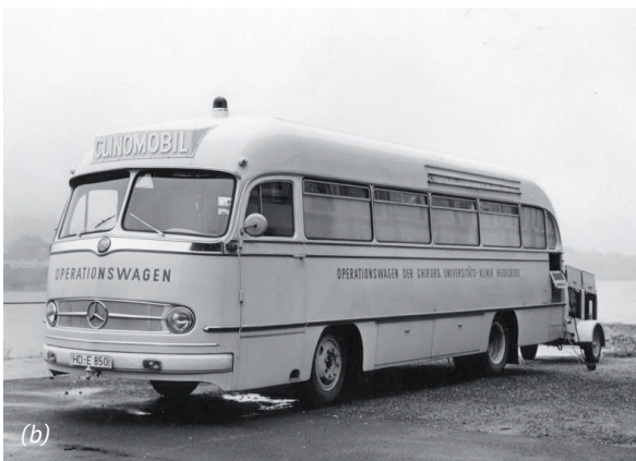
Abbildung 5.16: Das Clinomobil wurde am 5. Februar 1957 von Karl Heinrich Bauer eingeführt. Der mobile OP-Wagen mit 7 Mann Besatzung stellte eine Weiterentwicklung auf dem Weg zum heutigen Notarztwagen dar.
