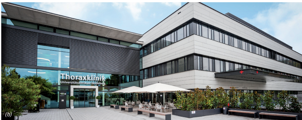
Abbildung 5.53 : Im Rohrbacher Schlösschen (a) entstand ein Tuberkulose-Krankenhaus, aus dem die Thoraxklinik (b) hervorging.
