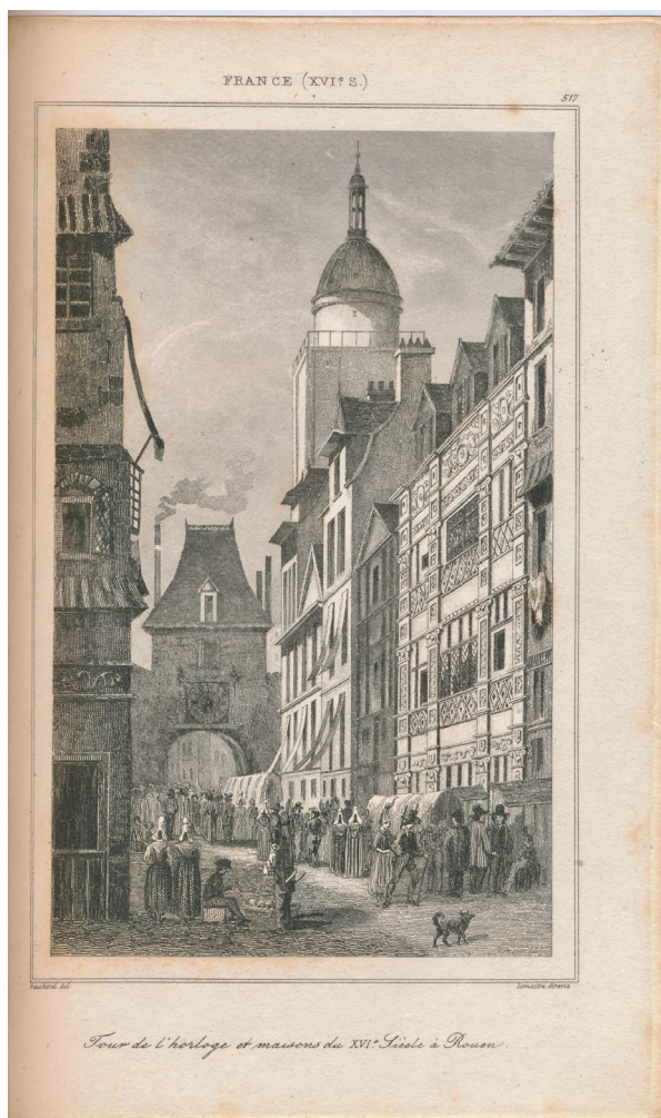
Abb. 109 Augustin-François Lemaître nach Gaucherel, Tour de l'horloge et maisons du XVI e siècle à Rouen , in: Augustin-François Lemaître, France. Planches du Dictionnaire encyclopédique , 1845, Bd. 3, Taf. 517
