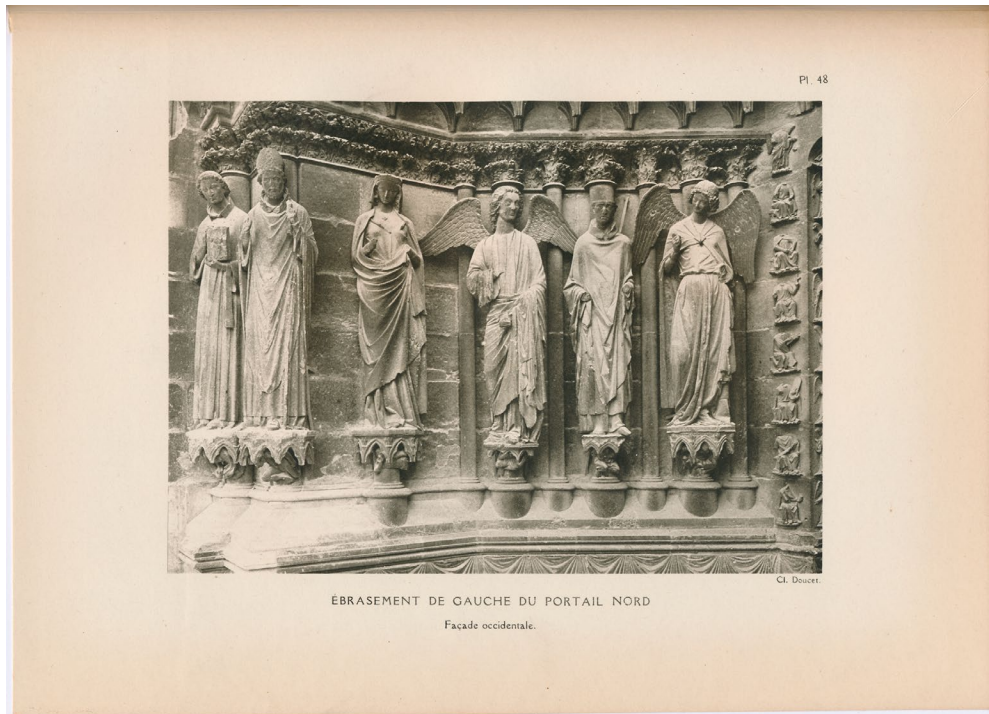
Abb. 39 [Cliché Doucet] Ébrasement de gauche du portail nord. Façade occidentale , in: Étienne Moreau-Nélaton, La Cathédrale de Reims , 1915, Taf. 48
