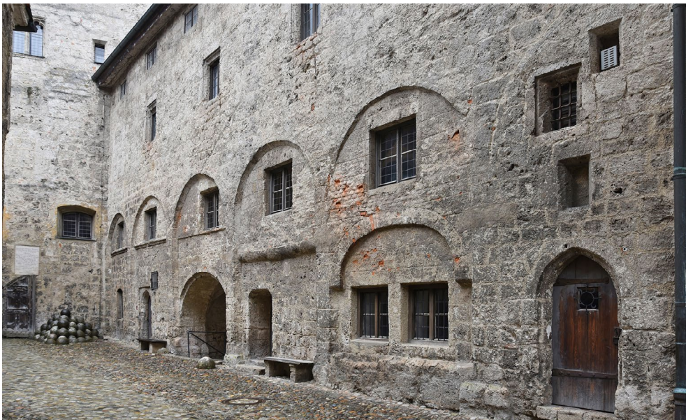
Abbildung 167. Ulrich Pesnitzer, Fassade Kemnatenbau mit vorgeblendeter Arkadengliederung, um 1485. Burg, Burghausen
