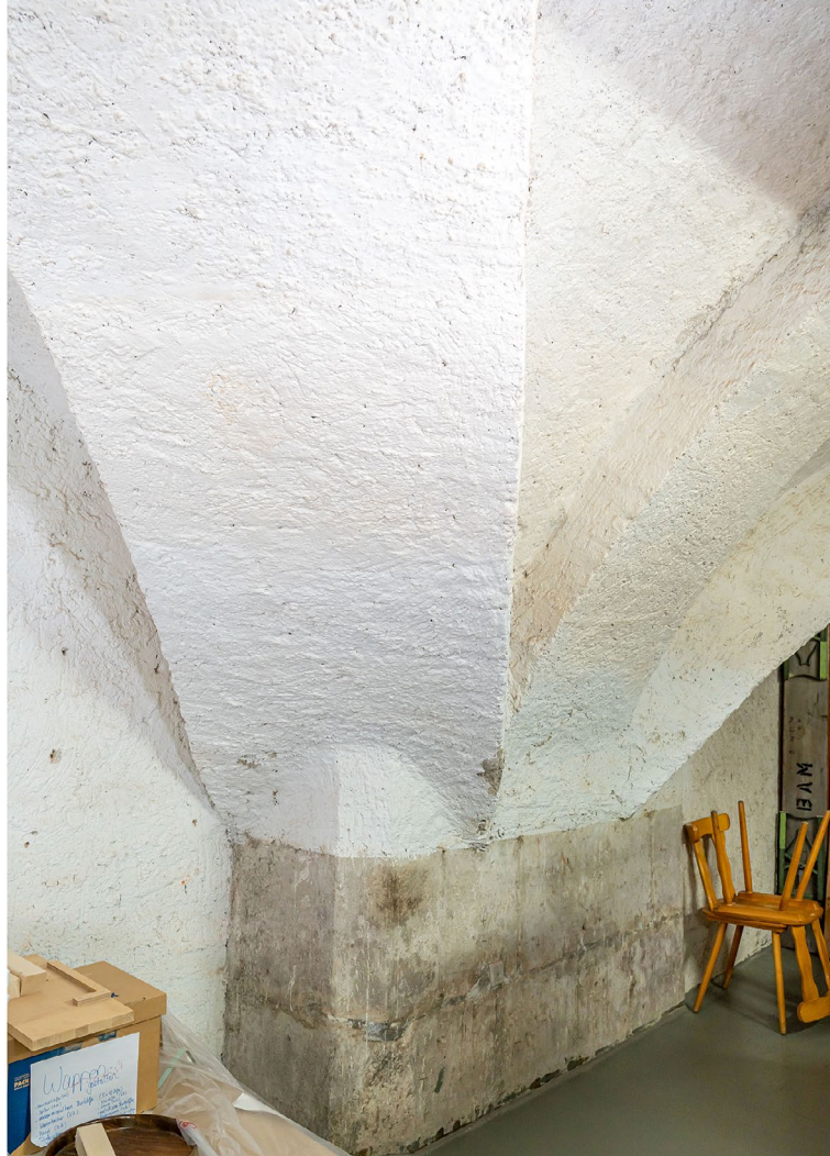
Abbildung 159. Pfeiler im südlichen Keller des Neuen Schlosses Ingolstadt
