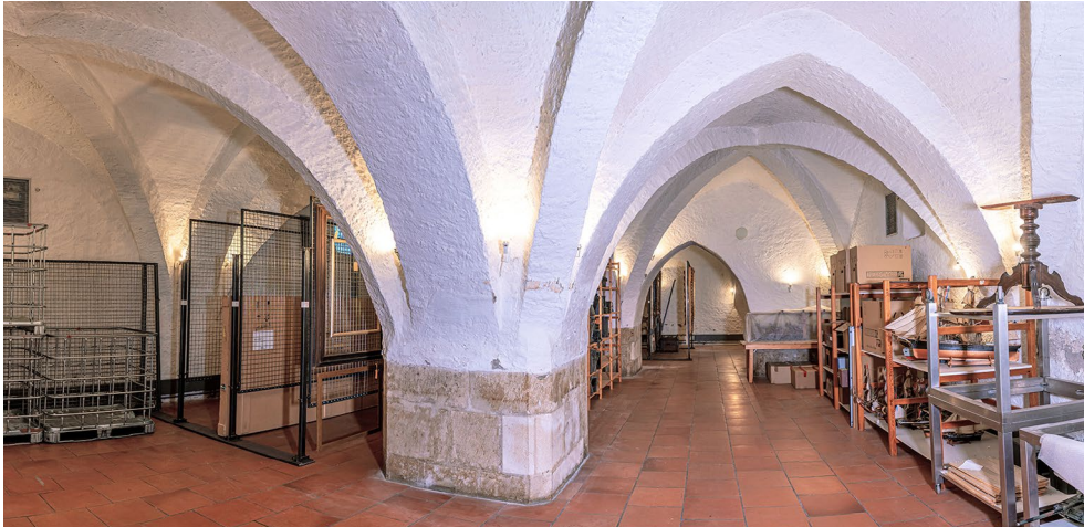
Abbildung 160. Blick in den nördlichen Kellertrakt des Neuen Schlosses Ingolstadt
