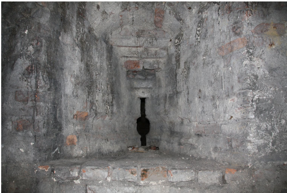
Abbildung 54. Residenz München, südwestlicher Geschützturm, nördliche Schießscharte, Foto: 2017, JL
