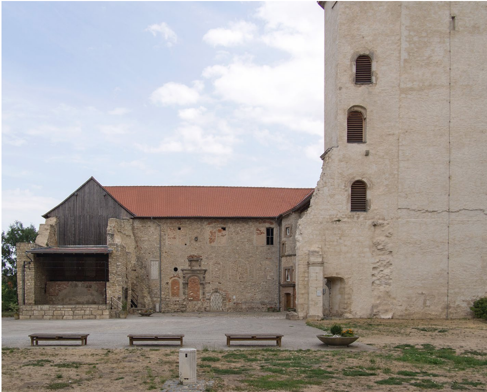
Abbildung 161. Osterwieck, Schloss Hessen, Schlosshof mit Burgturm (rechts), Ost- und Südflügel, Ausbau ab 1560 bis Mitte des 17. Jahrhunderts, Ansicht von Westen. In der Westfassade des Ostflügels zeigen drei Rundbogenfenster und ein aufwendig gestaltetes Portal von 1654(i) die Lage der ehem. Schlosskapelle an.
