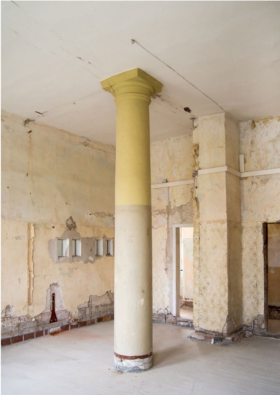
Abbildung 146. Prettin, Schloss Lichtenburg, Flügel B, erstes Obergeschoss, ehem. Hofstube (1.7) mit Säule, 1577–1582, Ansicht von Südwesten
