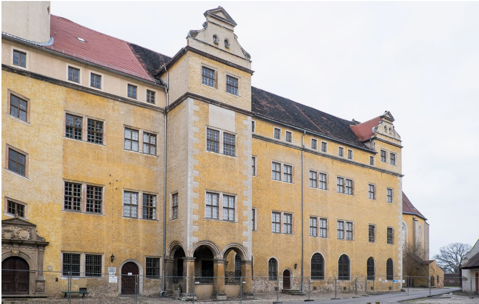
Abbildung 125. Prettin, Schloss Lichtenburg, Flügel D1, Hoffassade mit vergrößerten Rundbogenfenstern im Erdgeschoss, kurz nach 1611, Ansicht von Südwesten
