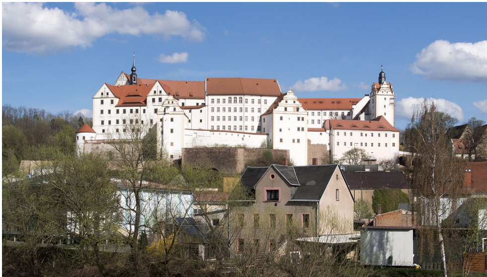
Abbildung 49. Colditz, Schloss Colditz, Hauptbauphasen: 11.–12. Jahrhundert, 15. Jahrhundert, 1519–1525, um 1600, Ansicht von Westen
