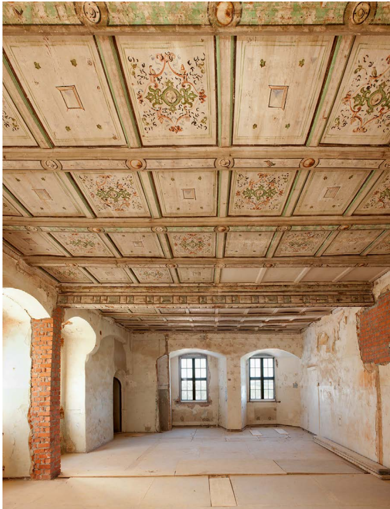
Abbildung 53. Colditz, Schloss Colditz, Kellerhaus, erstes Obergeschoss, ehem. K 1.2–K1.3, zusammengefasst zu K 1.2 nach neuer Zählung, Holzdecke um 1583/84, Ansicht von Osten
